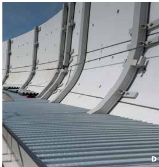
C ____ Gradins préfabriqués et portiques coulés en place.
