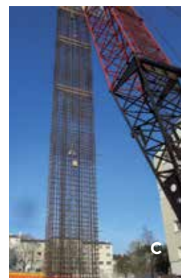
Chantier de la ligne B du métro de Rennes – intégration des tuyaux géothermiques : A. dans les cages d'armatures du radier, C. dans les piédroits, puis reliés à une pompe à chaleur B.
