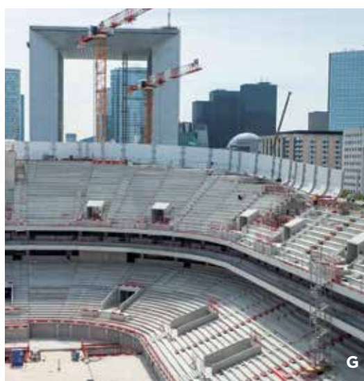
G ____ L'Arena : seul ouvrage en courbes dans un univers rectiligne.
