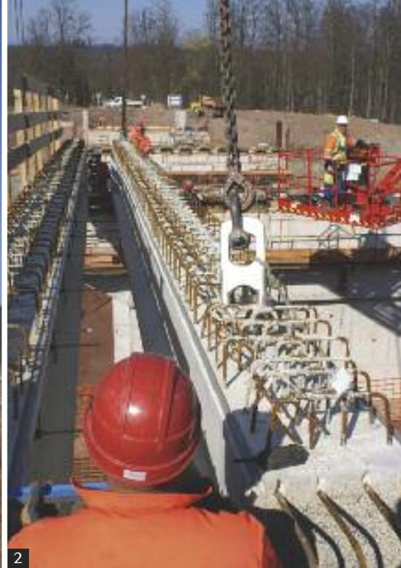
→ 1, 2 et 3 • Sur la LGV Est-européenne, plusieurs ponts-routes font appel à la technique des poutres en béton précontraintes par fils adhérents (PRAD).
