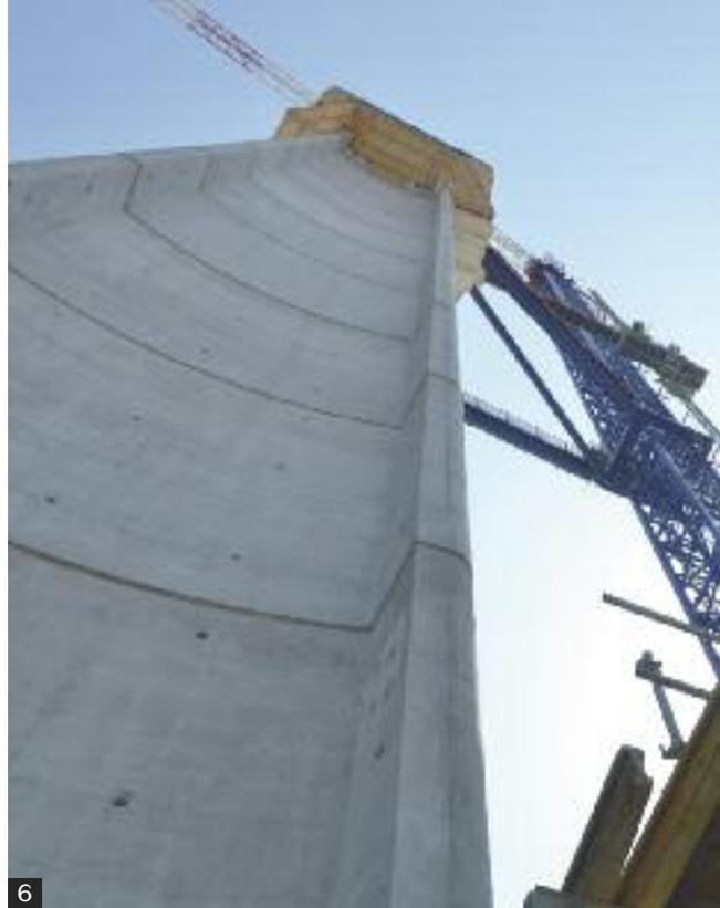
→ 5 • Les pylônes ont été coffrés au moyen de coffrages semi-grimpants. 6 • L'homogénéité de la teinte des parements a fait l'objet d'une attention soutenue.
