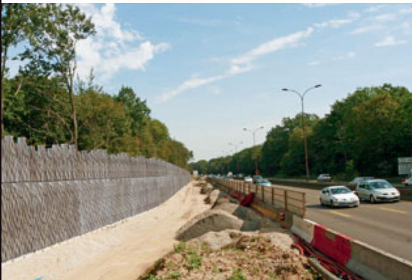
>>> 1 600 m d'écrans acoustiques sont en cours d'installation sur l'autoroute A13, dont le trafic va s'accroître avec la mise en service du nouveau tronçon de l'A86.
