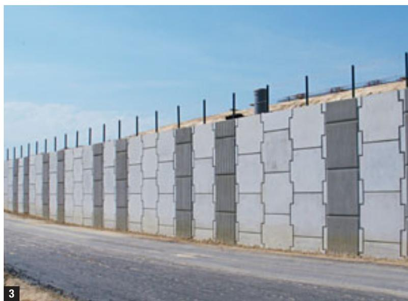
>>> **1** Le viaduc sur la Maine, tablier mixte acier-béton, d'une longueur totale de 530 m est composé de sept travées de 63 m et de deux travées de 44 m. **2** Les piles, au dessin original, ont été conçues par le cabinet d'architecture Lavigne. **3** Les éléments matricés du mur de soutènement en Terre armée® encadrent l'A11 sur 200 m.
