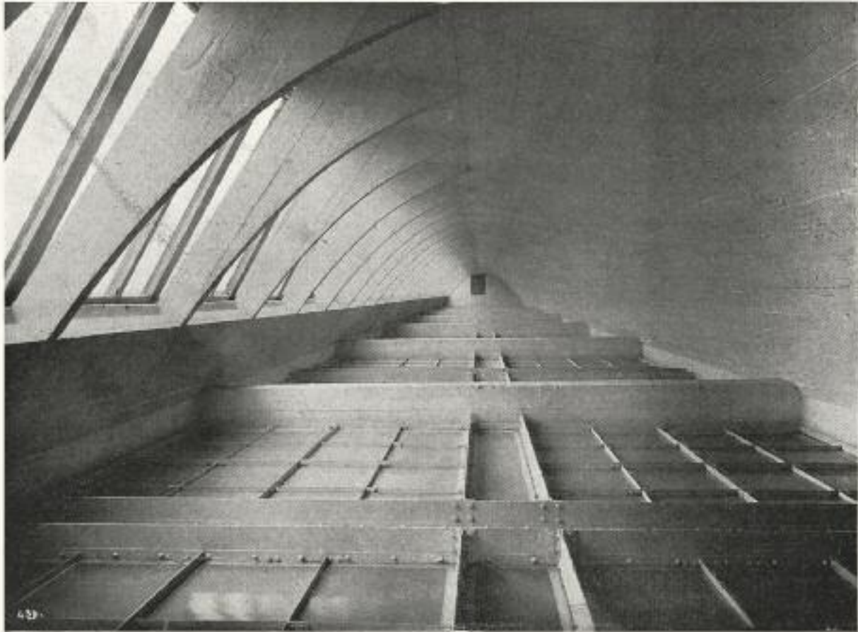
Palais du Mobilier National. — A.-G. Perret, Architecte.
