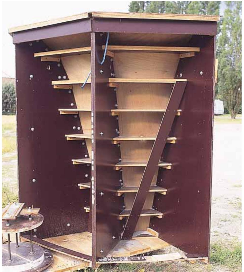
▲ Le coffrage devait être construit en bois et contreplaqué et être réemployable quatre fois au minimum.
