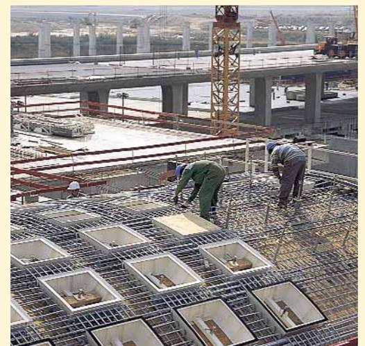
▲ Mise en place des armatures en acier galvanisé et des fenêtres de bétonnage sur le coffrage de la coque inférieure.
