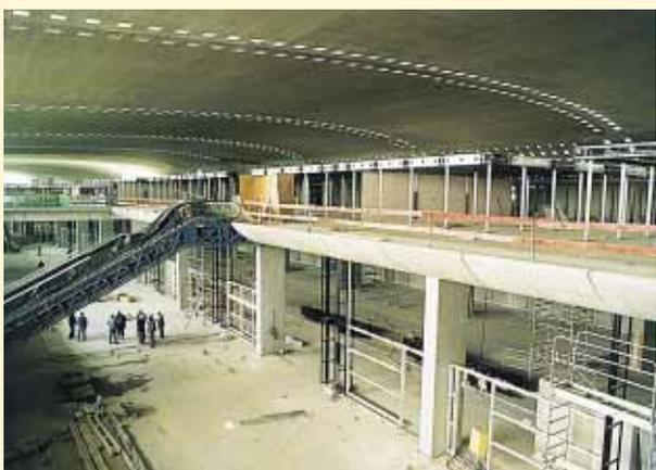
▲ Une grande homogénéité de teinte est obtenue sur les ouvrages en béton, qu'ils soient préfabriqués comme les rives de plancher, ou coulés *in situ* comme les poteaux et les voûtes.
