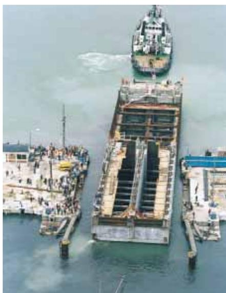
dans la cale sèche du port de Dieppe, avant d'être échoué sur le site. Il forme en plan un rectangle de 73 x 16,50 m. Ce caisson est composé de trois parties, la zone de logement des portes d'une hauteur de 16,50 m, la zone de passe constituée d'un radier en béton armé de 2,50 m d'épaisseur, et un massif d'appui des portes. Un remblai, soutenu par un rideau de palplanches, protège l'ouvrage des chocs accidentels causés par les navires. ■
