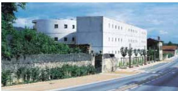
▲ Le mur de béton, percé de multiples petites fenêtres, protège des nuisances provenant de la nationale 7.
