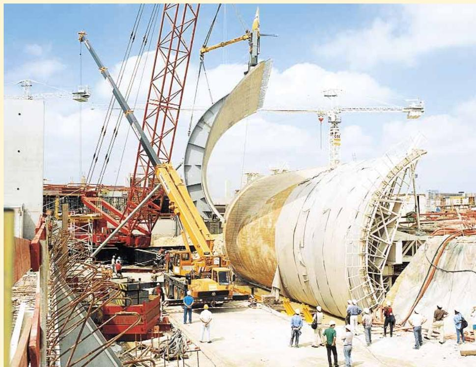
▲ Levage à l'aide d'une grue à flèche treillis de 1 000 tonnes d'une coque de "diacalse", coulée non pas en place comme les autres éléments, mais sur une unité de fabrication située au sol.
