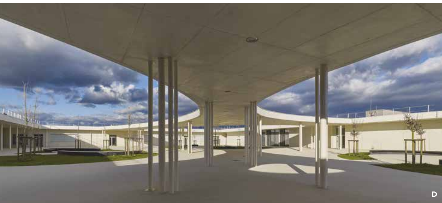
D ____ La couverture partielle de la cour crée des cadres vers le ciel.
