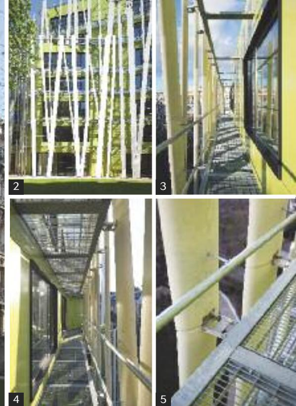
→ 1 et 2 • La résille en béton offre une perception changeante. 3 et 4 • La résille masque les coursives. 5 • Détail de la fixation.
