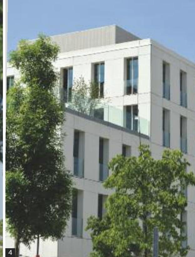
→ 3 • Des volumes différenciés. 4 • Un module de fenêtre unique, deux types de panneaux préfabriqués.
