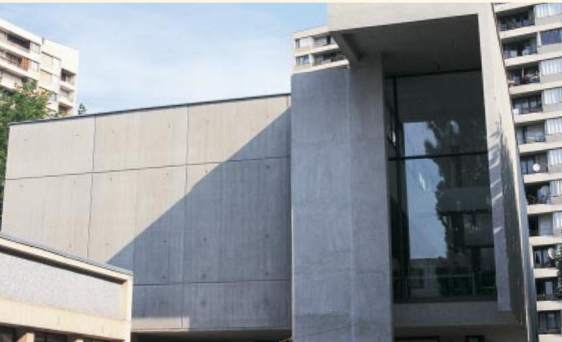
L'extension constitue le nouveau réfectoire du groupe scolaire. Le rez-de-chaussée se compose, pour l'essentiel, de poteaux qui supportent la dalle du niveau 1. Les voiles du premier étage, d'une hauteur de 7 m, sont positionnés à l'extrémité de la dalle, sur un important porte-à-faux côté rue. Coulés en une seule levée, bruts de décoffrage, ils présentent un fini matricé façon planchettes en bois.
