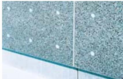
employé. Il faut aussi veiller à la propreté des granulats. Dans le cas du calepinage de joints verticaux et horizontaux et de trous d'écarteurs de banche, des dessins très précis doivent être présents dans l'appel d'offre pour éviter toute tentative de modification.
