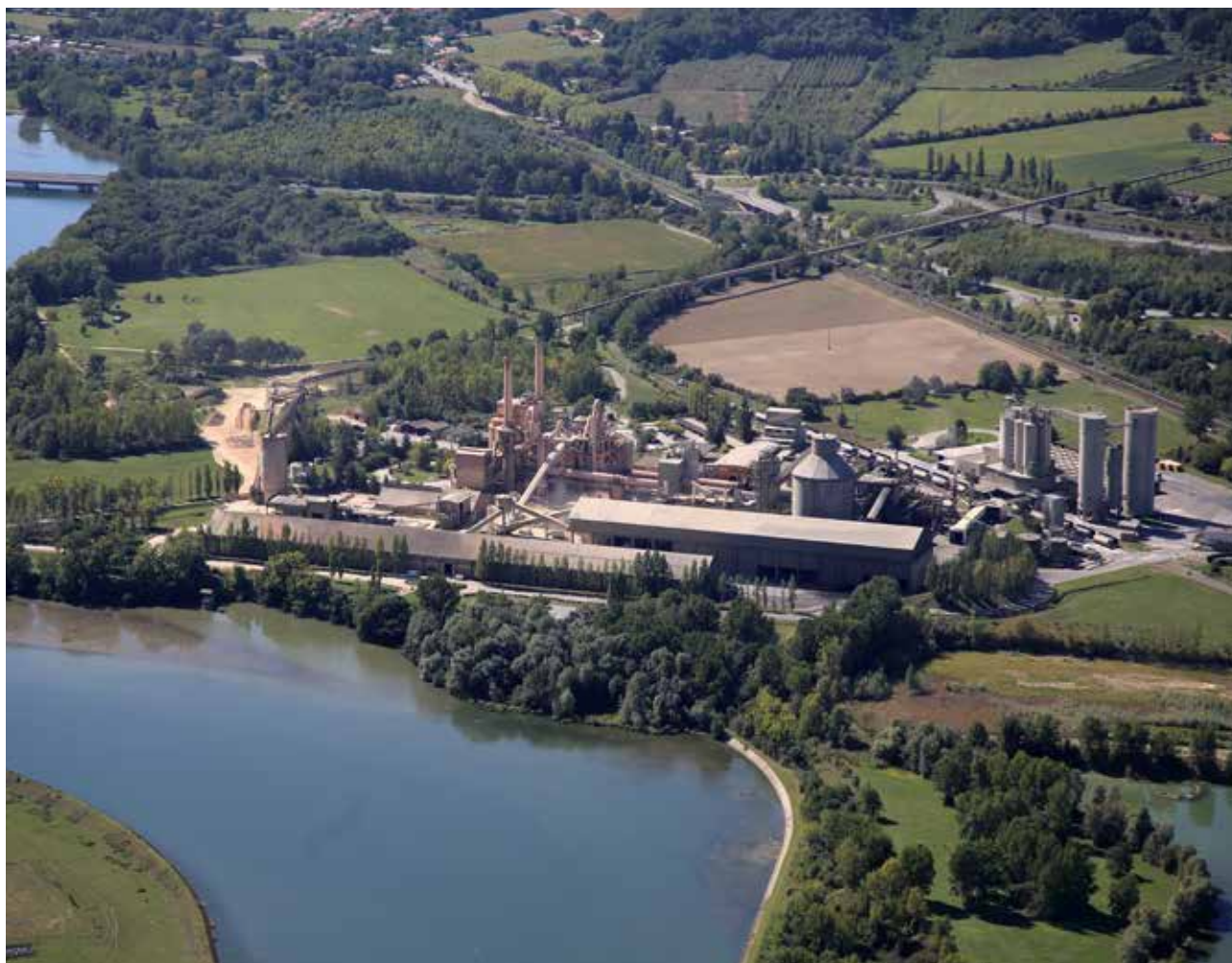
Vue aérienne du site de Martres-Tolosane, avant sa modernisation.
