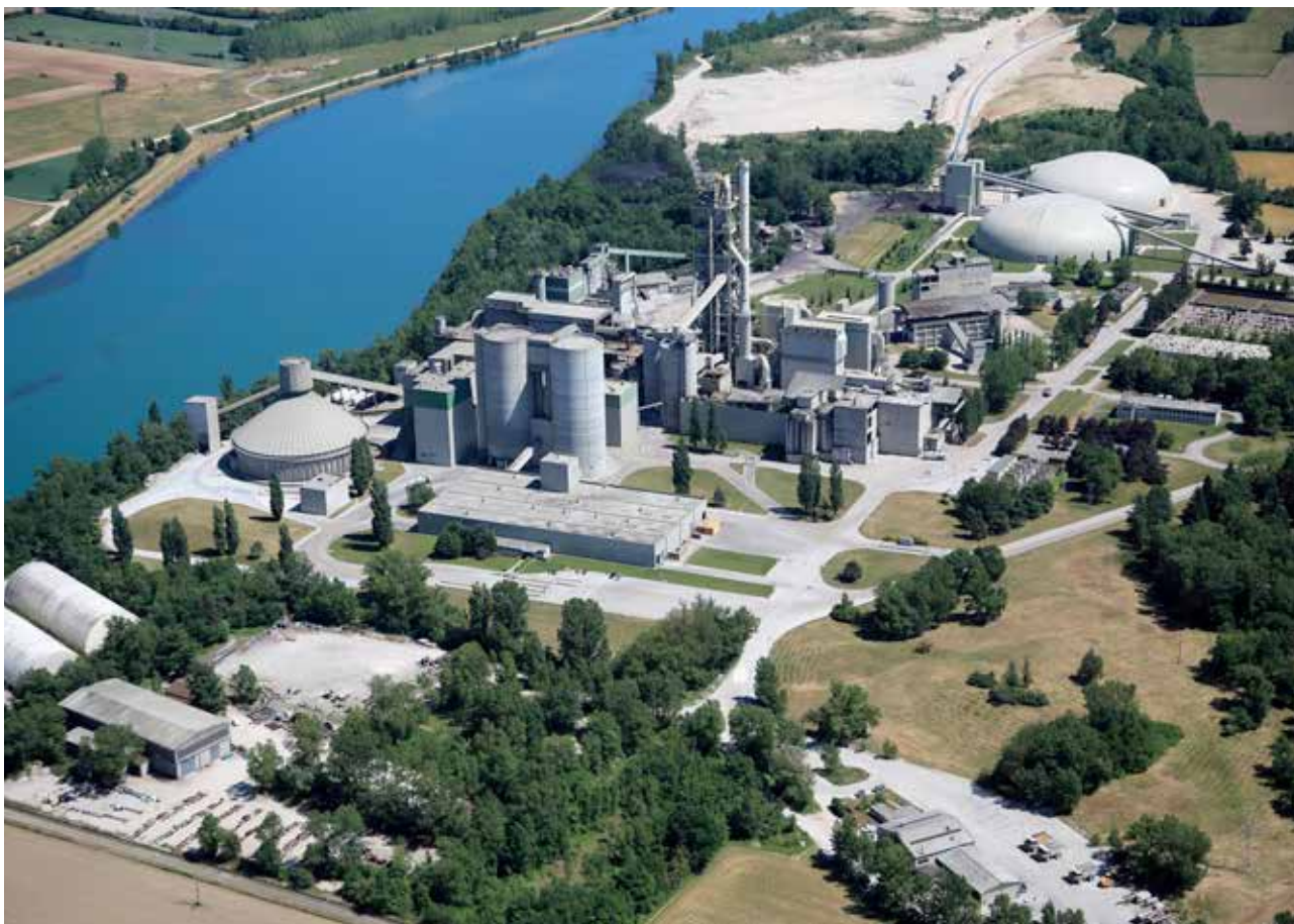
La cimenterie de Montalieu applique la valorisation des terres non inertes sur son propre site.
