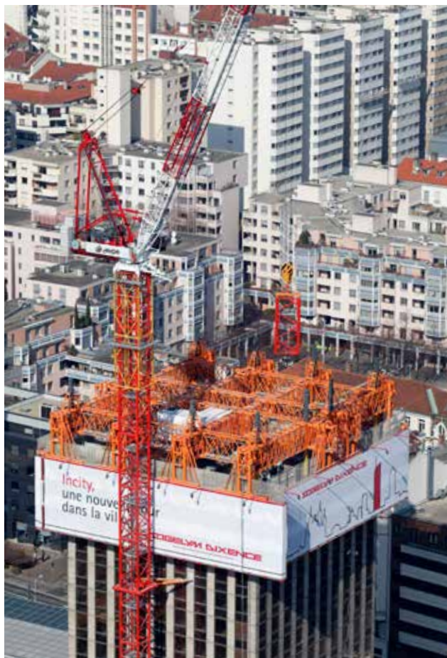
Déconstruction douce grâce à un système de protection qui descend au fur et à mesure de la démolition.
