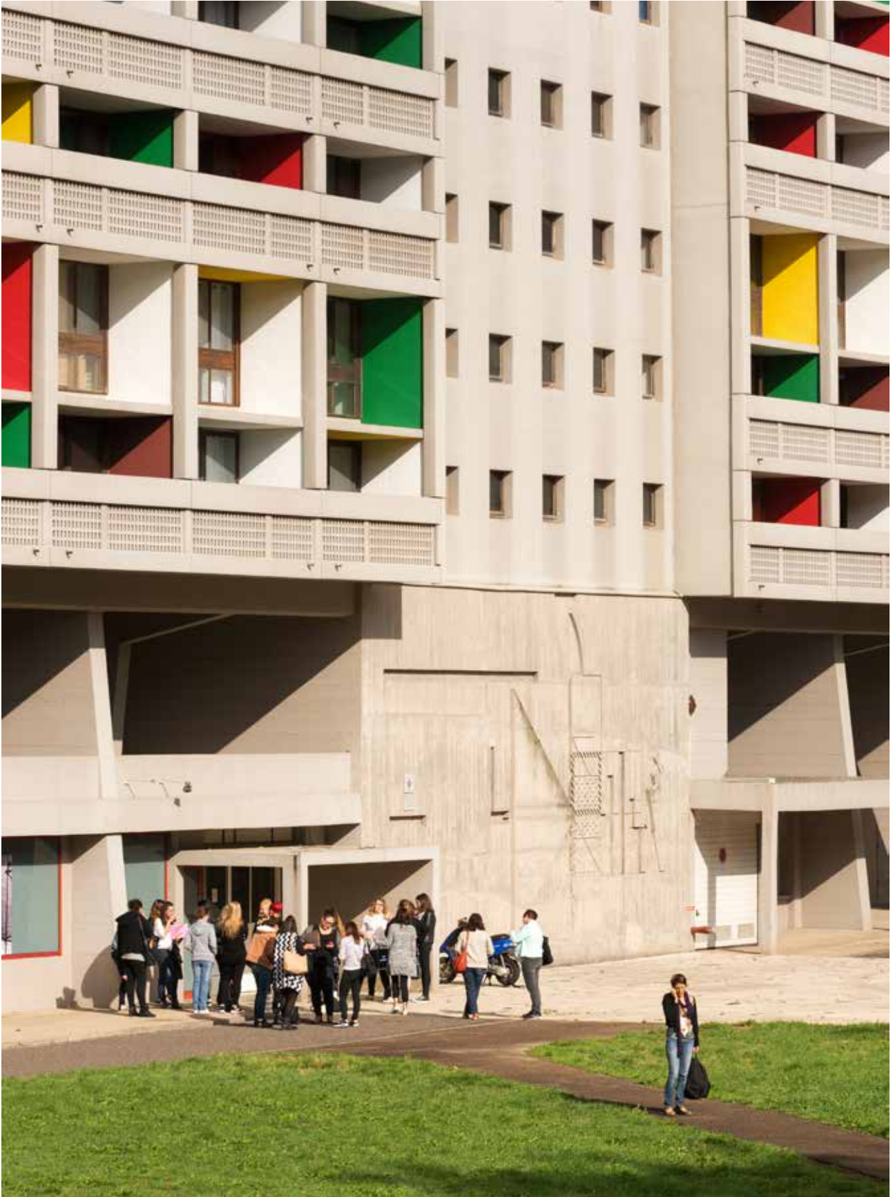
Au pied de la Cité radieuse de Le Corbusier, à Marseille.
