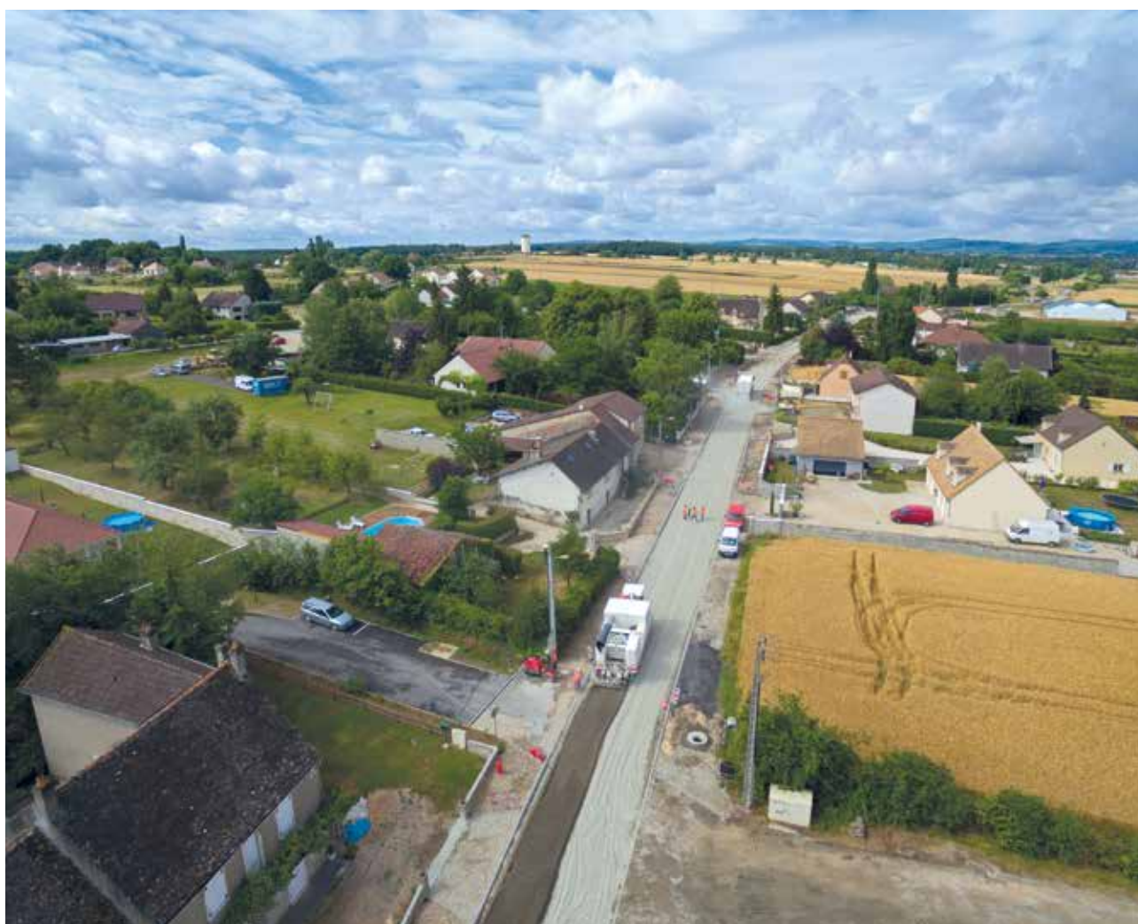
A Demigny (Saône et Loire), portion de la D62 réalisée en 2 jours (900 m long et 6-7 m de large) par Eiffage Route.
