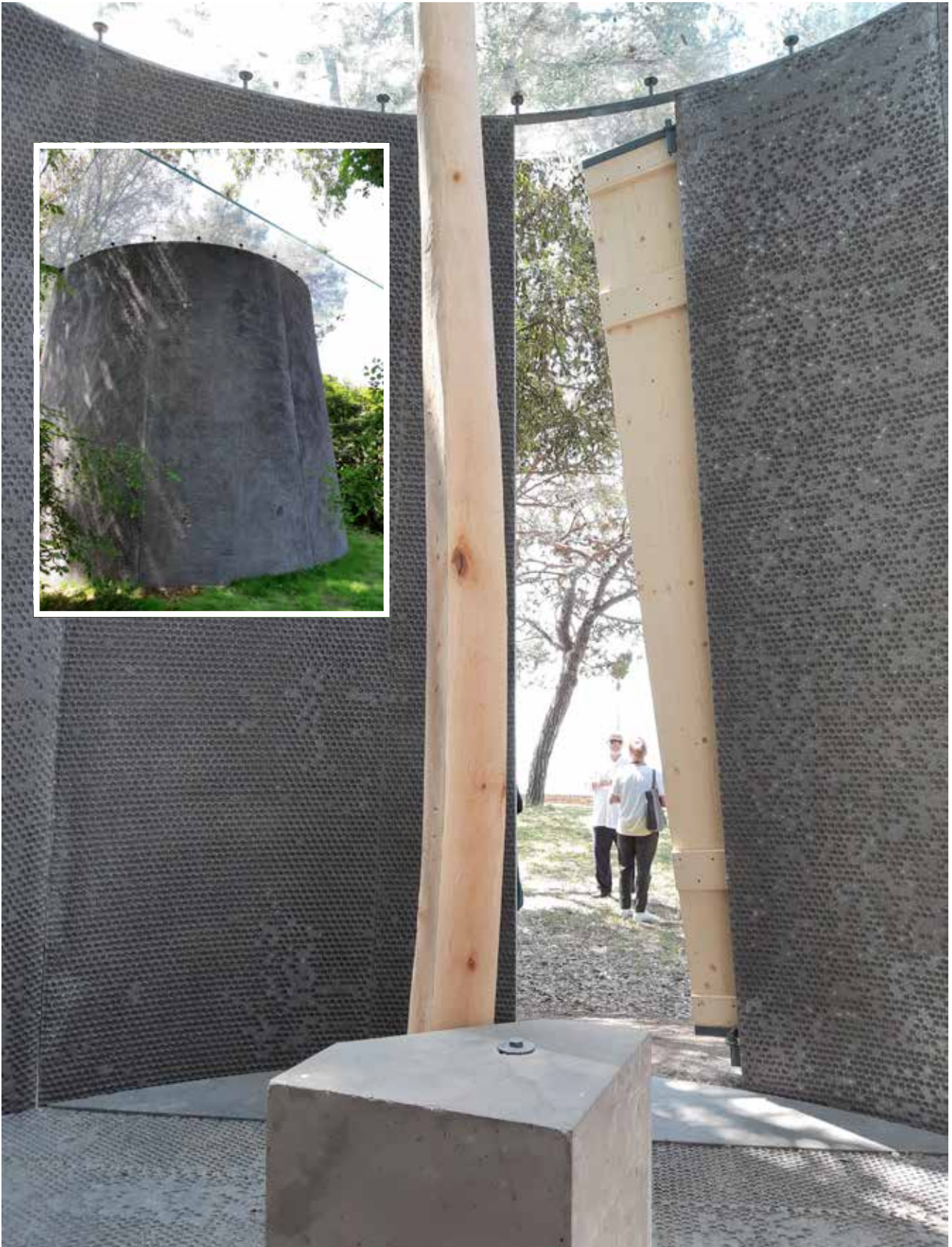
▲ Une chapelle du Vatican se sert du béton pour un espace de recueillement minimaliste. Conçue par le chilien Smiljan Radic, celle-ci met en valeur la lumière, accrochée par la surface de la paroi intérieure moulée dans du papier à bulles. Inattendu aussi la présence de l'architecte Peter Zumthor dans l'axe de la porte au moment de la prise de vue !
