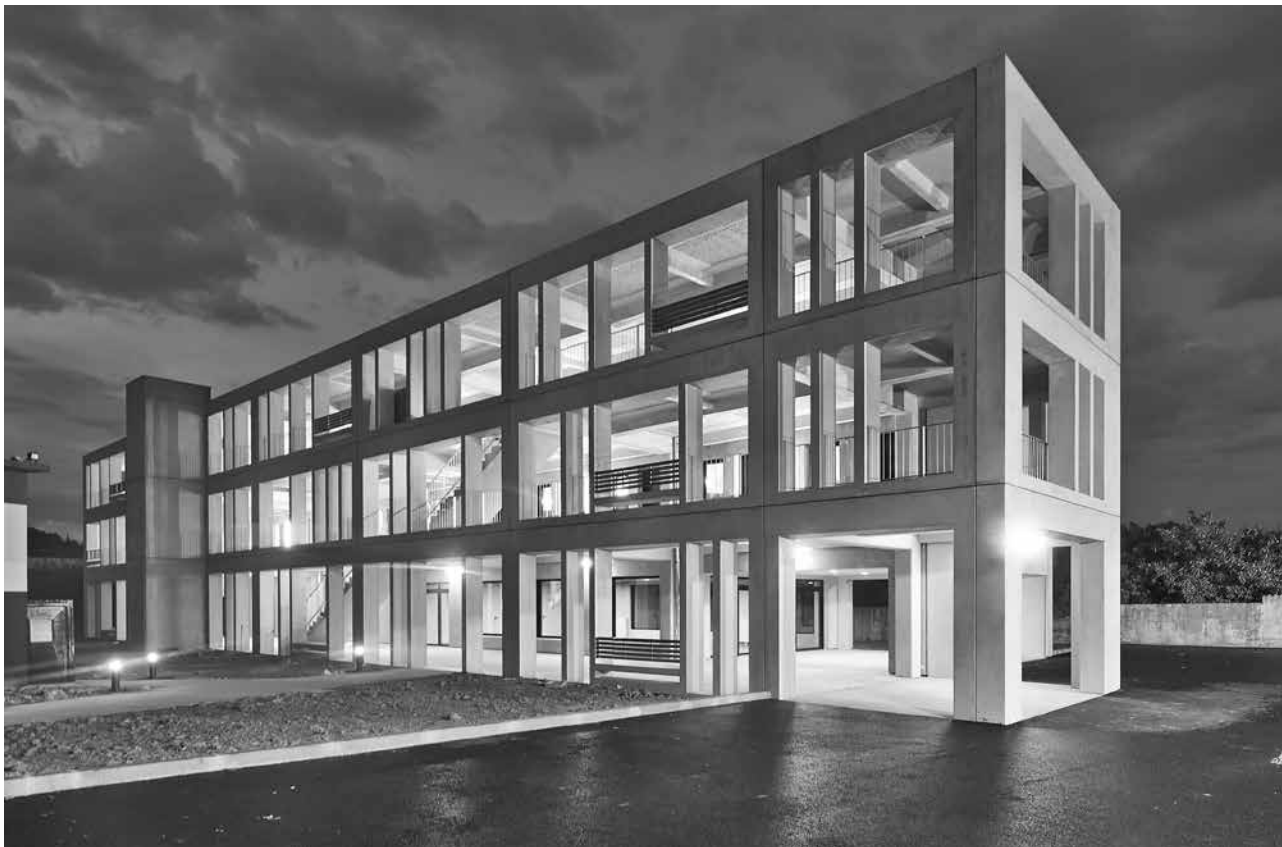
Foyer de 23 logements pour les compagnons d'Emmaüs à Agen. (MOA : Agen Habitat).
