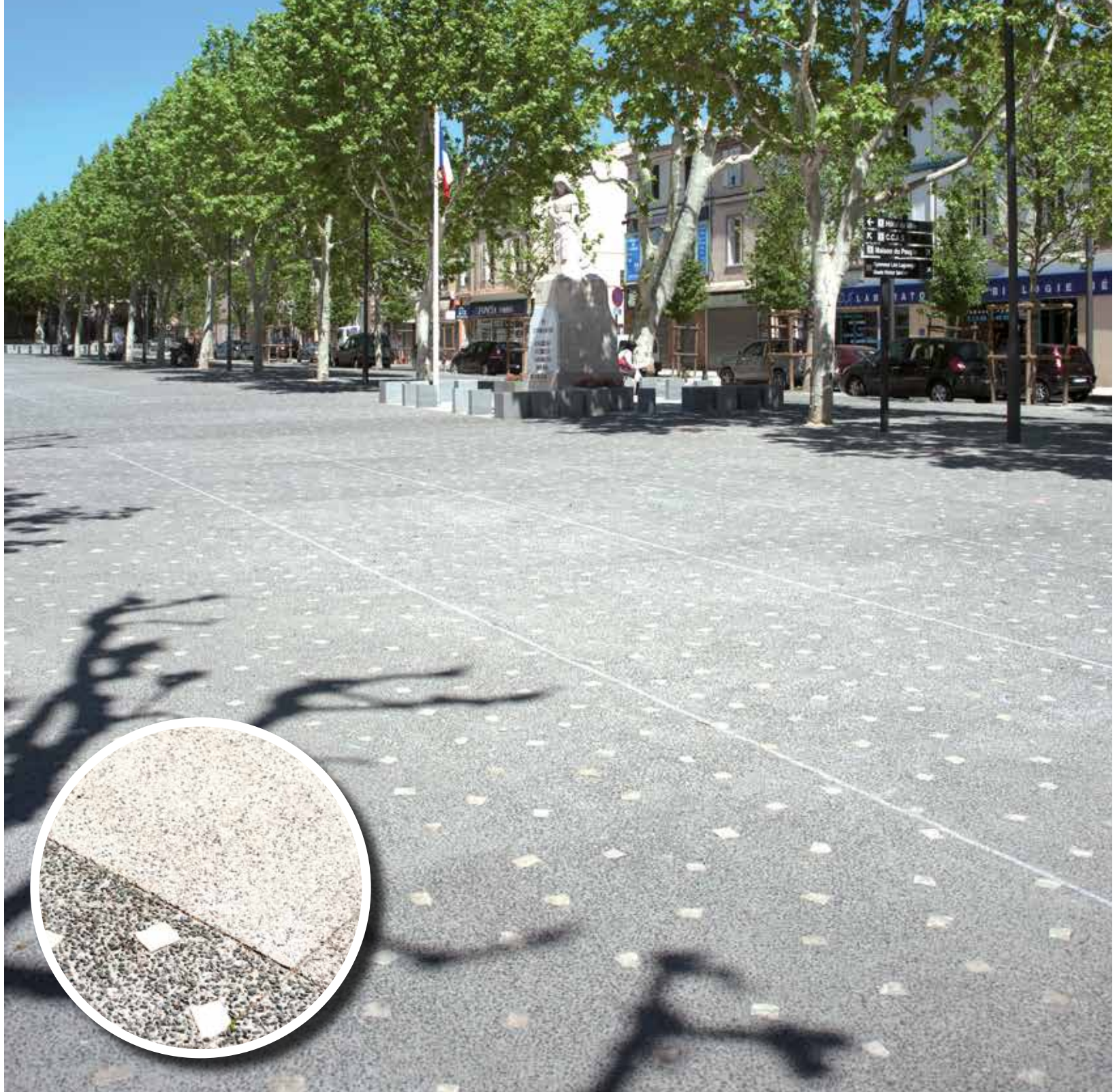
Le cours du centre-ville de Gardanne (Bouches-du-Rhône) a été réalisé avec un béton innovant comportant des inclusions de pavés calcaires. MATÉRIAUX UTILISÉS : Béton désactivé avec inclusions de pavés calcaires MAÎTRE D'OUVRAGE : Ville de Gardanne MAÎTRE D'ŒUVRE : Plan Séquences Architectures et Bérim (BET) ARCHITECTE : Philippe Ghezzi
