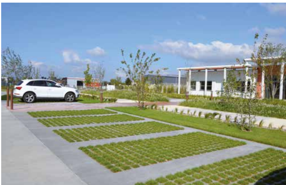
Procédé breveté Via Verde® : centre aquatique Diabolo de Bourg-de-Péage et places de stationnement dans la zone d'activité de Fiancey, à Livron-sur-Drôme.
