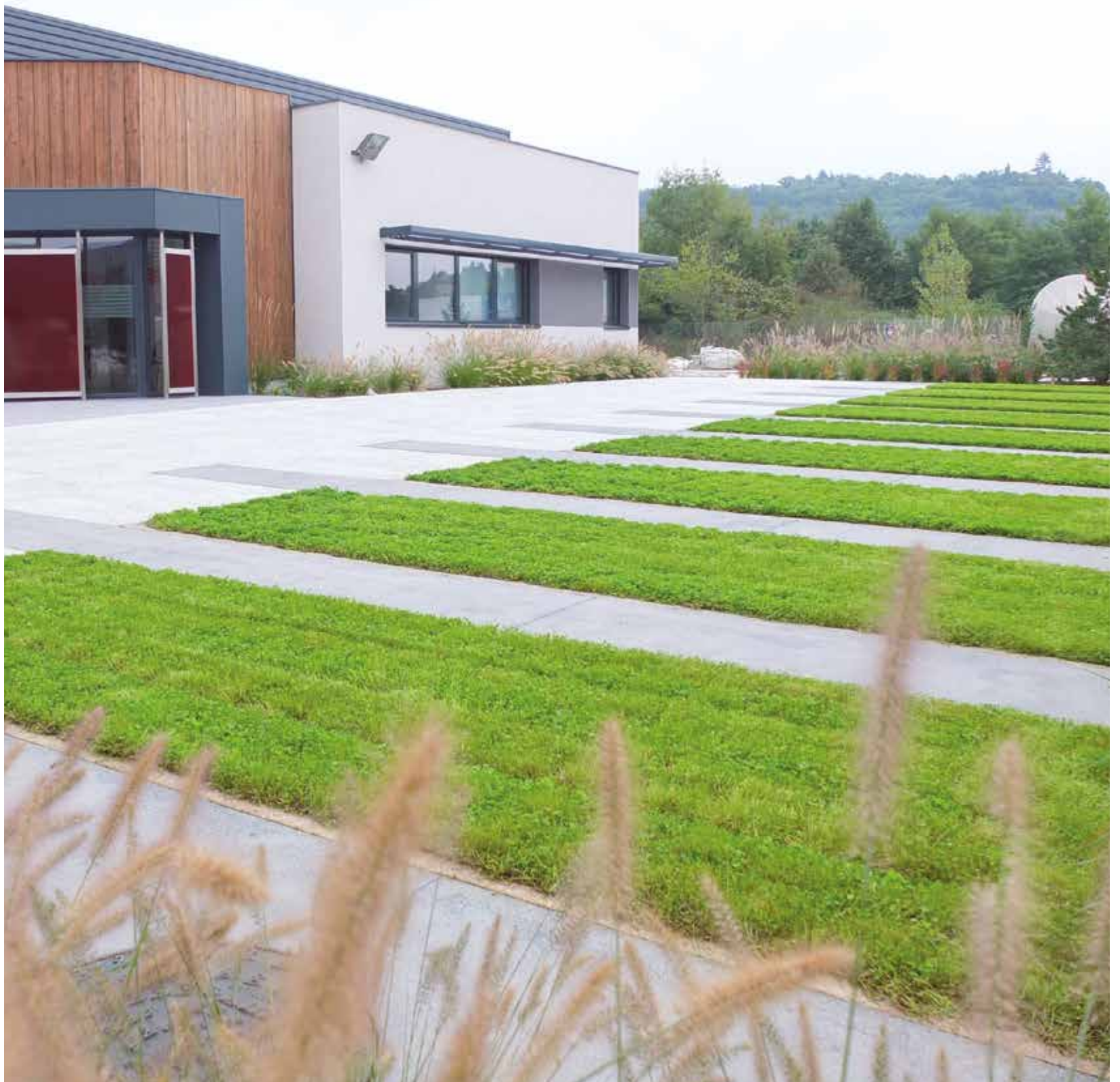
Places de stationnement du parking de Sols Confluence, Vourles, Rhône. MATÉRIAUX UTILISÉS : Béton végétalisé Via Verde® (procédé breveté) MAÎTRE D'OUVRAGE : Sols ARCHITECTE : Sandrine Ligonnet, Idesia
