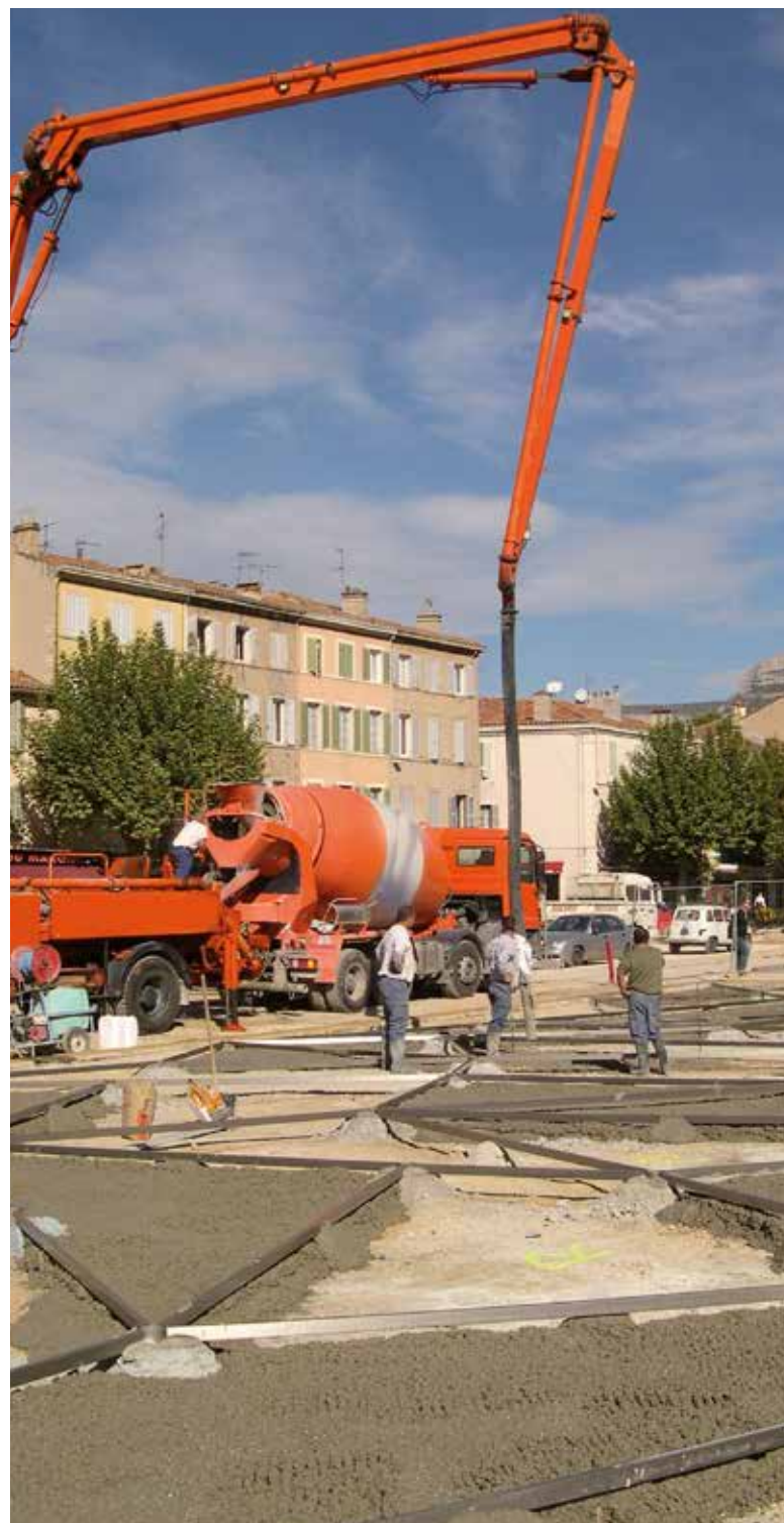
À Aubagne, sur le cours Voltaire, des caissons en inox, découpés au laser, ont été installés pour faciliter le coulage des bétons désactivés de sept couleurs différentes. Puis les bétons ont été lissés avec soin, avant l'application d'un désactivant.
