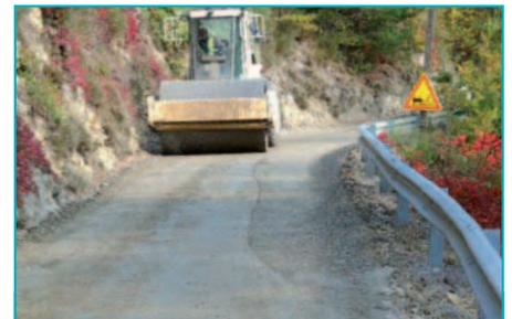
Compactage avec un cylindre lisse, associé à un compacteur sur pneus.
